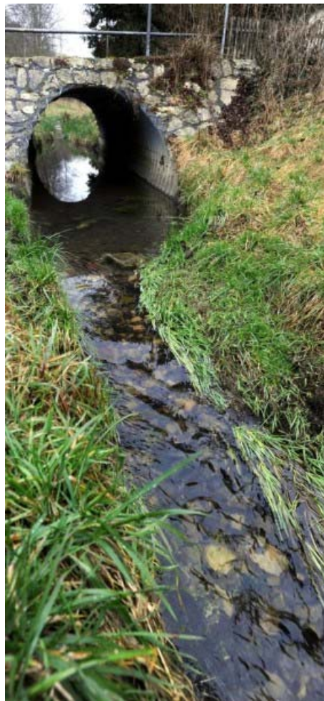
Der Mühlbach in Aystetten soll renaturiert werden.
