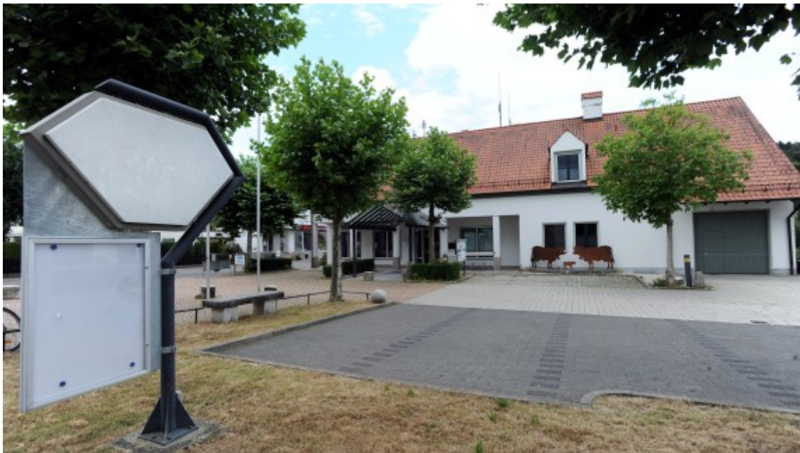
Immobilie Metzgerei Rössle in Aystetten wird zwangsversteigert.
